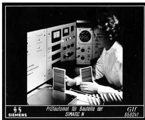
Instalación para constatar Simatic N
