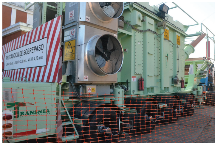
Nuevo transformador móvil de 30 MVA de potencia de Transnea.
