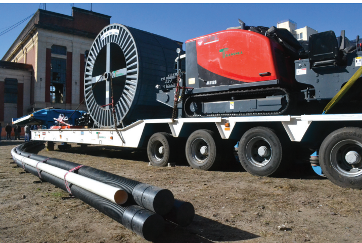
Tuneladora adquirida por Transnea para cavar subterráneamente minimizando las molestias en calles y veredas, y un tramo del caño corrugado que recubrirá al cableado.
