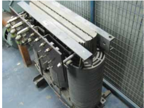
Figura 5. Transformador objeto de estudio.
