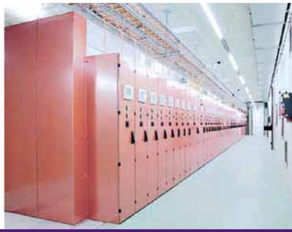
Figura 4. GIS con la nueva mezcla de gases instaladas en Zúrich.
