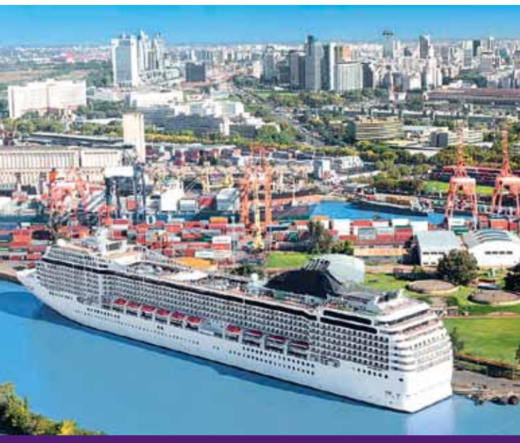
Figura 1. Atracados en un muelle, los buques pueden consumir grandes cantidades de energía eléctrica. Frecuentemente, esta energía es suministrada por los motores diésel del buque, lo que puede causar un impacto adverso sobre el medioambiente local.
