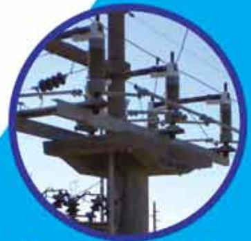
Seccionador Tripolar para uso en S/E
