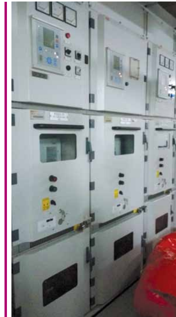
Vista de los tableros eléctricos de la sala de máquinas
