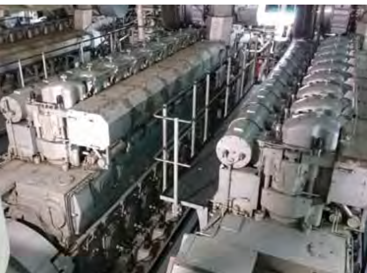
Vista de los cuatro generadores diesel Man de propulsión principales. El rompehielos opera, en navegación normal, con uno solo de ellos a una velocidad crucero de diez nudos
