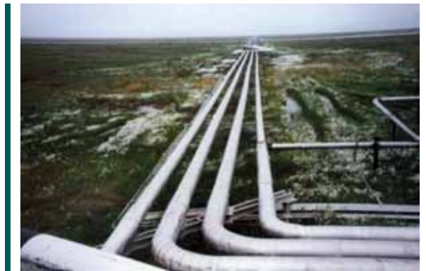
Figura 1. Estaciones de compresión para estaciones de gas natural: protección anti-surge, medición y regulación de caudal
