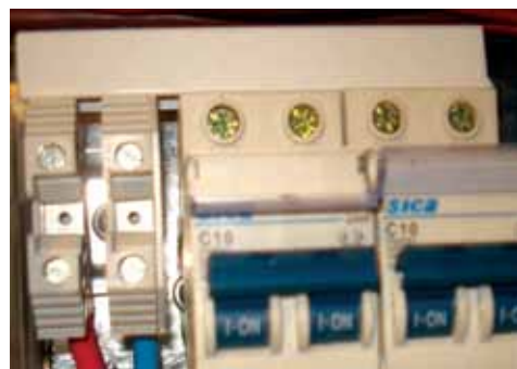
Ejemplo de conexión reglamentaria de elementos de maniobra y protección en un tablero, utilizando una combinación de conductores, borneras y peines de conexión.
