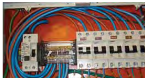
Ejemplo de alimentación reglamentaria a los dispositivos de maniobra y protección del tablero seccional por medio de un distribuidor.
