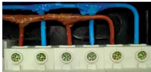
Ejemplo de conexión reglamentaria de elementos de maniobra y protección en un tablero de hasta tres circuitos de salida realizada por medio de un "puente" con conductores flexibles de sección adecuada.
