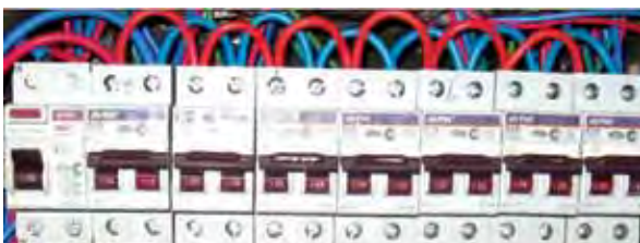
Ejemplo de conexión no reglamentaria de elementos de maniobra y protección en un tablero seccional (comúnmente denominada conexión "guirnalda"),
