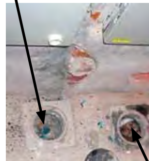
Toma a tierra del sistema de puesta a tierra de protección del usuario
