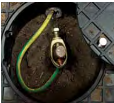
Ejemplo de Instalación de toma de tierra (Jabalina) reglamentaria, con caja, tapa de inspección y su conexión al Conductor de puesta a tierra (PAT) con su correspondiente tomacable debidamente conectado.
