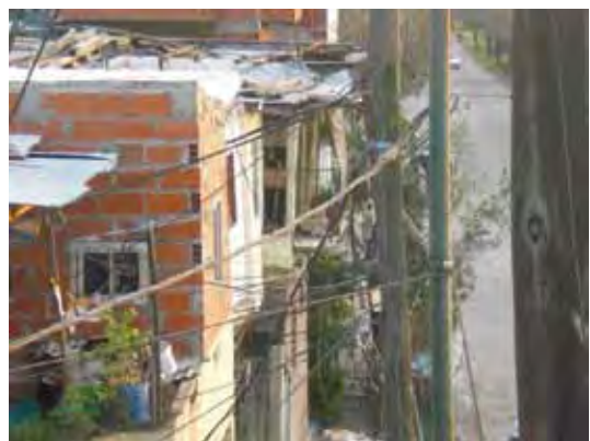
Redes aéreas precarias
