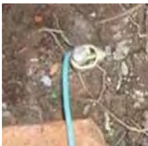
Ejemplo de instalación de toma de tierra (jabalina) no reglamentaria, en el que se observa la ausencia de la caja y tapa de inspección, a la vez que el conductor de puesta a tierra no cuenta con la debida protección mecánica.
