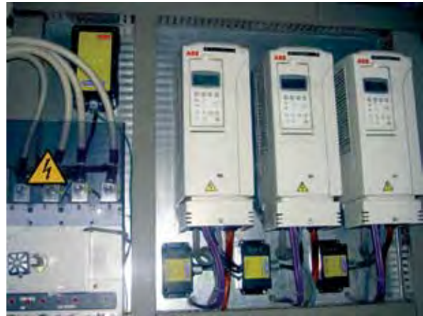
Protección de variadores
