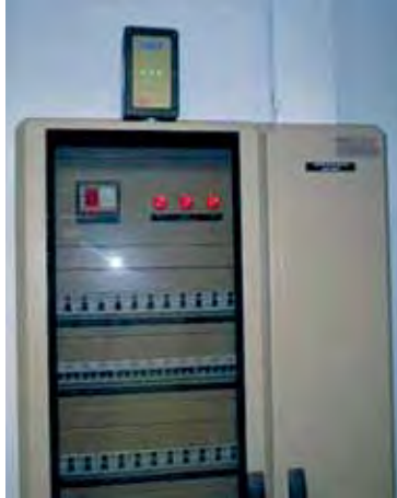
Techo de gabinete
