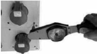
Verificación de torque de apriete
