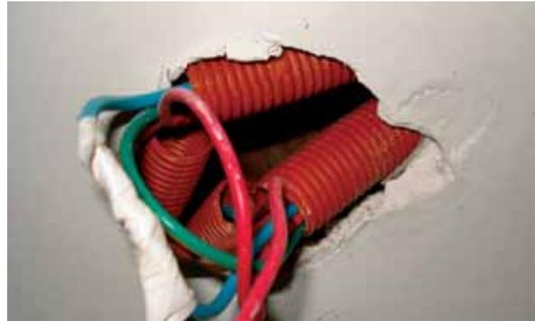
**Ejemplo de instalación eléctrica en cielorraso suspendido no reglamentaria, en la que se puede observar la ausencia de la caja reglamentaria, la utilización de caño corrugado color naranja, el cual directamente no es apto para instalaciones eléctricas en inmuebles, y al igual que el ejemplo anterior, el peso de la instalación está soportado directamente sobre el cielorraso suspendido, en lugar de lograr una estructura rígida y que no esté soportada por el propio cielorraso suspendido.**
