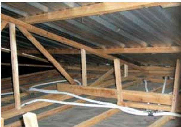
**Ejemplo de instalación eléctrica en cielorraso suspendido no reglamentaria, donde se puede observar que se utiliza un tipo de caño no permitido para ese uso, de manera que no genera una estructura rígida, y además el peso de la instalación está soportado directamente por el propio cielorraso.**
