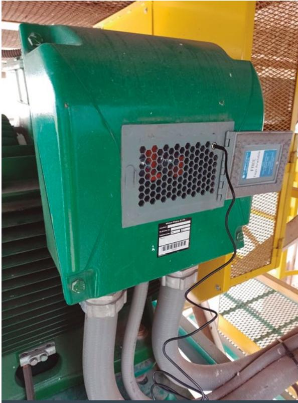
Sección a.3.6" para ser montadas en equipos de media y alta tensión (600 V a 38 kV revestidos de metal y 72 kV). Estas están revestidas de metal con forma de malla hexagonal que resiste los impactos y la carga desde todos los lados sin agrietarse, romperse o desprenderse.
