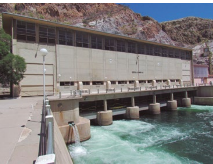
Central hidroeléctrica Nihuil 2 Fuente: Wikimedia Commons
