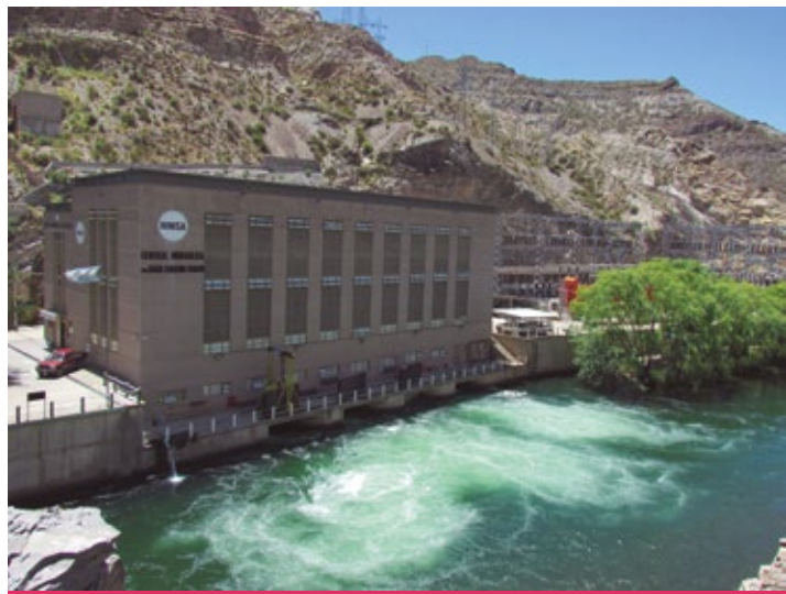
Central hidroeléctrica Nihuil 1 Fuente: Wikimedia Commons
