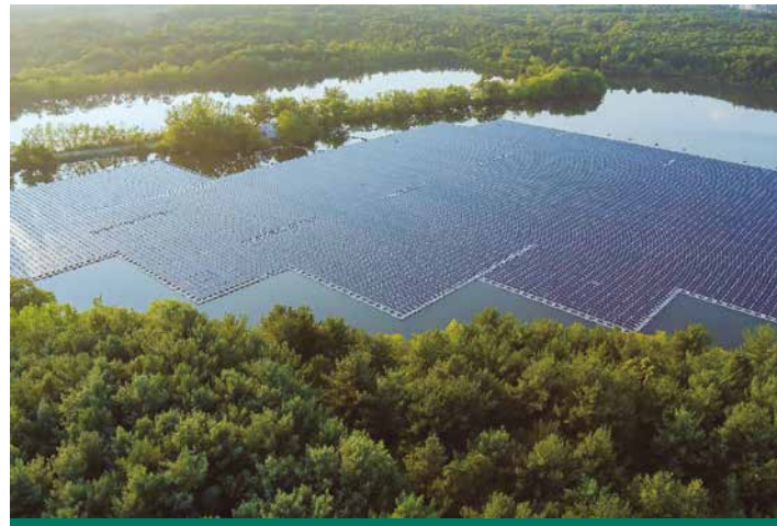
La fotovoltaica flotante utiliza la superficie de importantes masas de agua para instalar paneles fotovoltaicos
