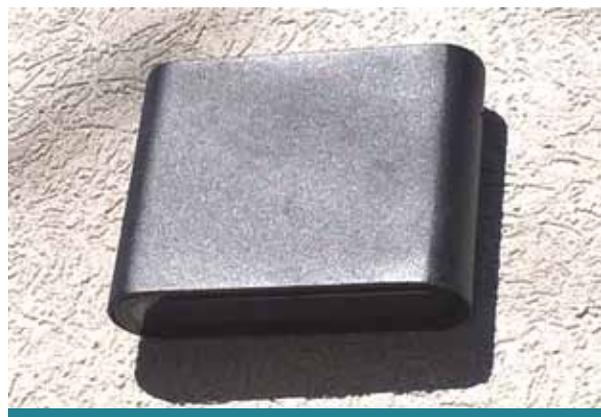
Figura 4a. Habrá que esperar algunas lluvias para que lágrimas de óxido decoren el revoque sintético
