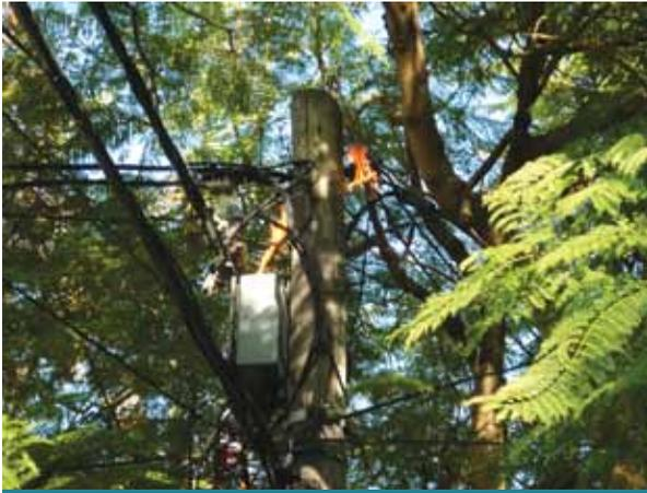
Figura 2a. "Preensamblado" en llamas por calentamiento en la transición (de paso, podemos recordar por qué no hay que instalar preensamblados en interiores)
