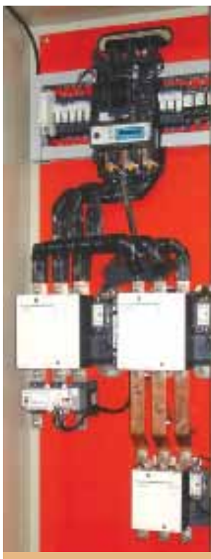
Figura 7. Tablero estrella-triángulo
