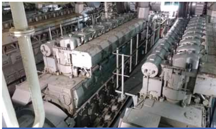
Vista de los cuatro motores de propulsión diesel
