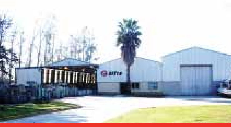
DiTra: División Transformadores, en la ciudad de Tafí Viejo (Tucumán), presta servicio de mantenimiento y reparación de transformadores de distribución eléctrica
