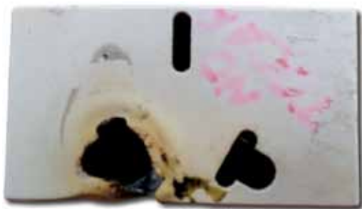
1. Toma binorma (antirreglamentario) dañado por sobrecarga
