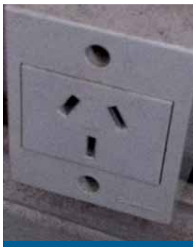
2. Toma de veinte amperes (20 A), reglamentario
