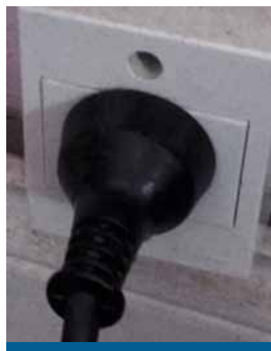
4. Ficha de diez amperes (10 A) enchufada "de prepo" en el toma de veinte amperes (20 A)
