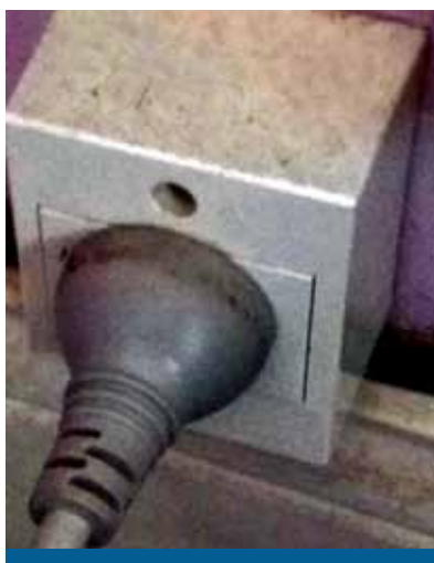
3. Ficha de veinte amperes (20 A) enchufada en su toma correspondiente
