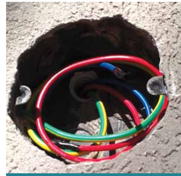
Figura 3. Caja de chapa amurada sobre fachada (exterior) con mortero que contiene cal, garantía de corrosión
