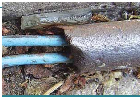
Figura 4d. Tampoco instalar unifilares bajo piso; aunque el caño estuviese entero, lo más probable es que igual quedase lleno de agua.
