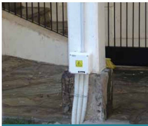
Figura 4b. Bajo tierra, usar solo cable para uso subterráneo reglamentariamente protegido, jamás unifilares bajo corrugado enterrado, que mantendrá los cables sumergidos de por vida
