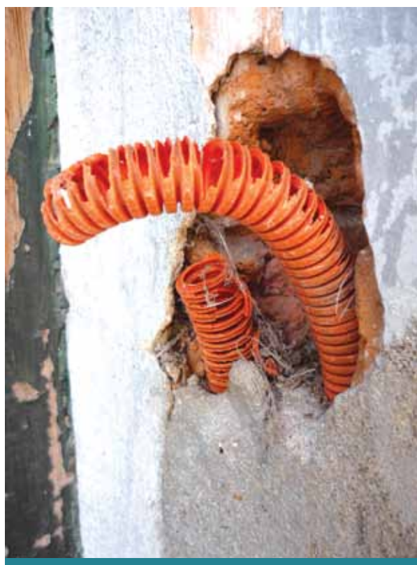
Figura 4c. ¡No colocar corrugados intemperie! Miren los efectos del ultravioleta
