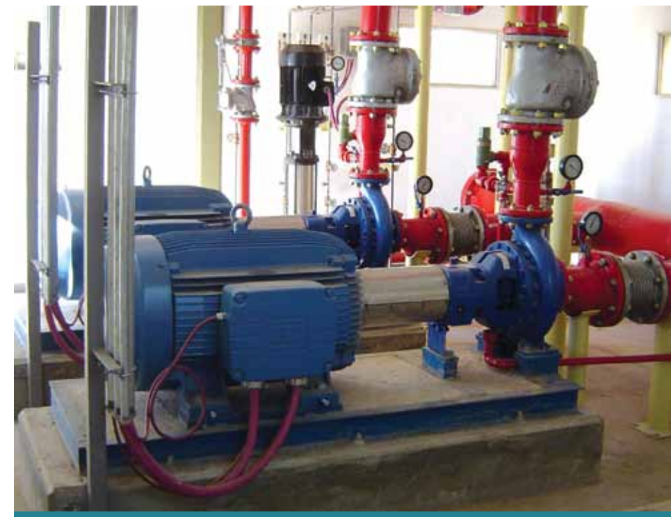
Figura 2. Conjunto motor eléctrico y bomba
