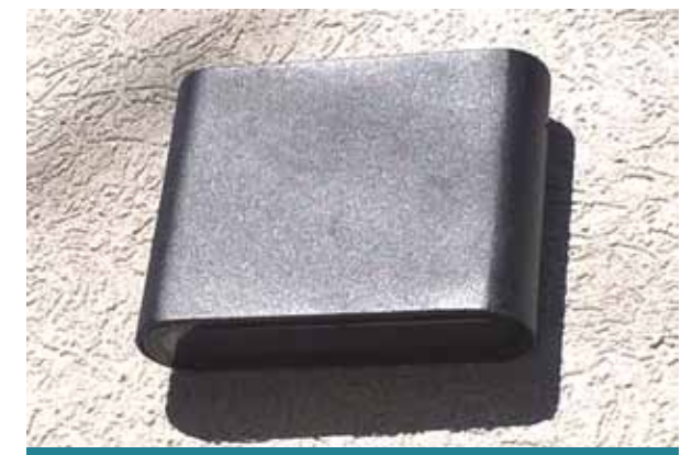
Figura 4a. Habrá que esperar algunas lluvias para que lágrimas de óxido decoren el revoque sintético
