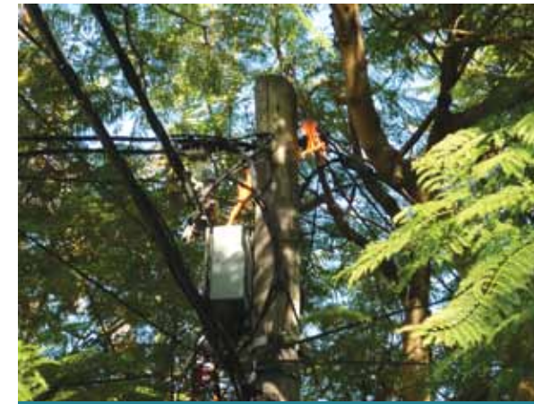
Figura 2a. “Preensamblado” en llamas por calentamiento en la transición (de paso, podemos recordar por qué no hay que instalar preensamblados en interiores)
