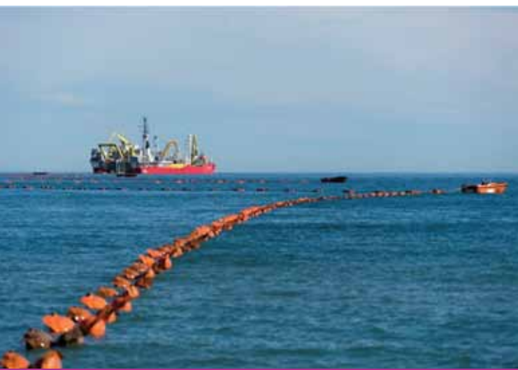
Figura 1. Actividades de tendido para cables submarinos (fuente TB610)
