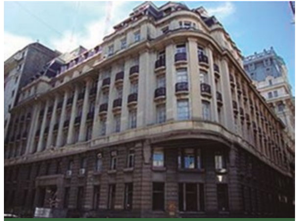
Edificio actual que fue sede de la central CATE, sobre Balcarce
