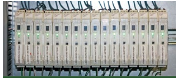
Figura 3. Una aplicación con alta densidad de transmisores de temperatura montado en riel DIN
