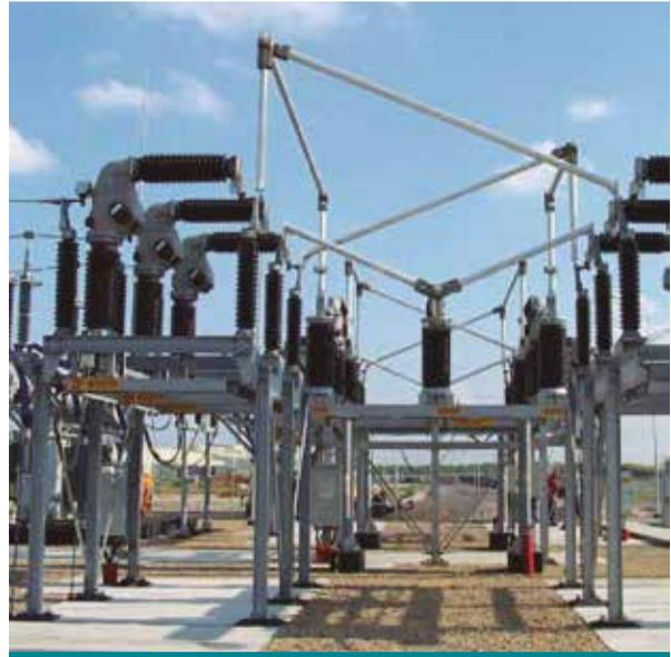
marcha, y ahorrara espacio. Todas las características del diseño responden a tales fines. Por ejemplo, el conjunto de barras autoportantes permite economizar el espacio porque no hay necesidad de tener aisladores de poste de barras para soportar el sistema de barra colectora, ya que el peso lo soportan los módulos Compass. Por supuesto, la reducción de tiempos y espacios mencionada se traduce luego en una baja en los costos operacionales. ■
