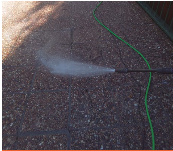
Figura 3. Hidrolavadora: chorro en forma de escoba, poco consumo, daño nulo y barrido eficaz
