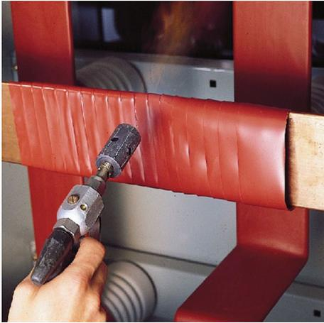
La cinta protege contra los puentes causados por aves y animales. La capa adhesiva fusiona las capas de cinta, pero no se adhiere, lo que proporciona un sellado ambiental al tiempo que permite una extracción rápida y fácil.
