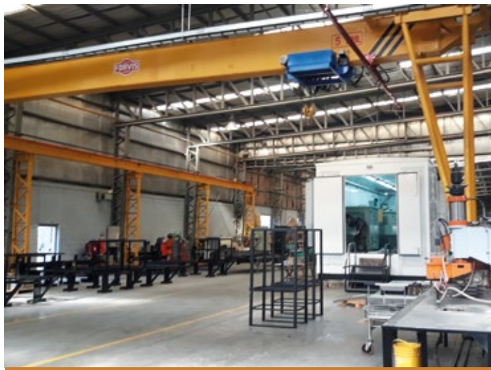
Pórtico de puente grúa
