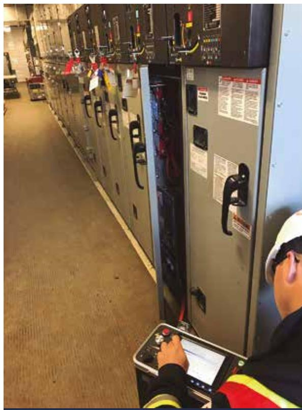
**Figura 3. Centro de control de motores**
