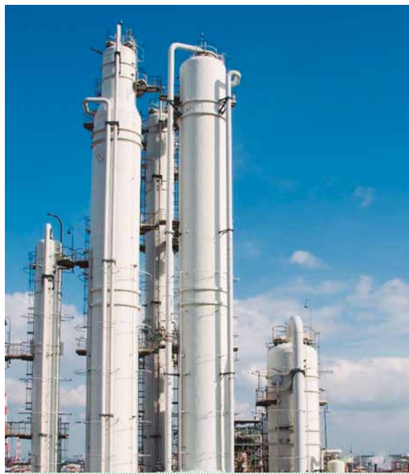
Columnas de destilación de la planta química de ENEOS Materials
